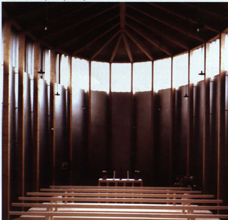
Interior de la capilla de Sogn Benedetg en Sumvitg.
